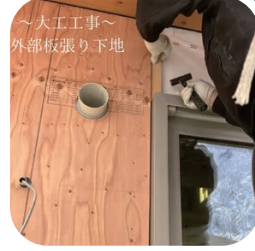
大工工事 [外工事の様子]
