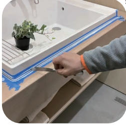
仕上げ工事 [内部防水・コーキング処理]
