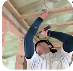
大工工事 [天井断熱材敷き込み～天井下地施工]
