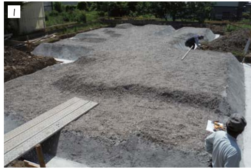
松本市岡田 Sさま邸 (新築・12月完成予定)
