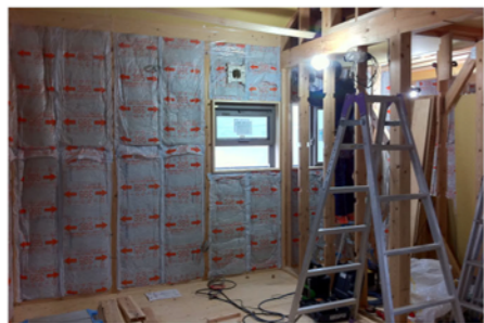
断熱材充填中
