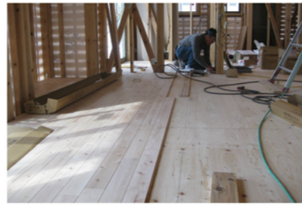
床板の施工中
