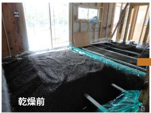
8. 蓄熱砂利の乾燥 (ヒーターを連続通電して砂利を乾燥させます)
