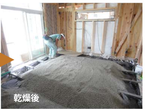
8. 蓄熱砂利の乾燥 (ヒーターを連続通電して砂利を乾燥させます)
