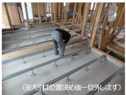
1. 鋼製束を設置
