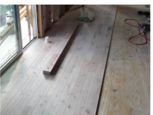
11. 無垢のカバ桜の床板を張り完了！！
